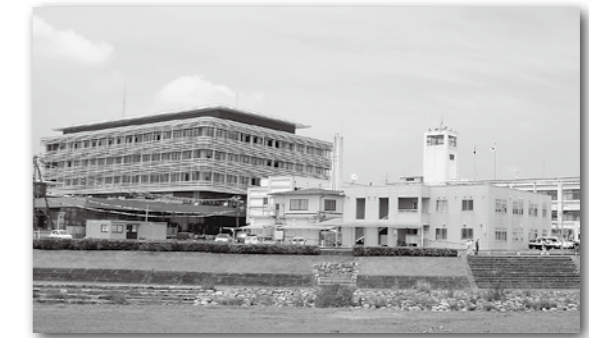
▲建設中の新庁舎(左)と現在の本庁舎
