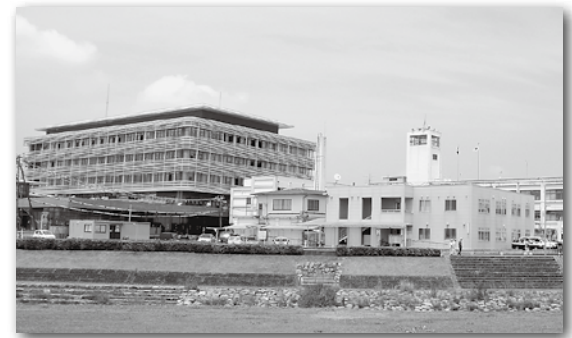
▲建設中の新庁舎（左）と現在の本庁舎
