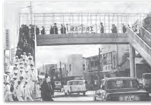
▲竣工式の様子（昭和 43 年当時）
