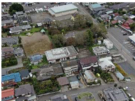
久下田浄水場
