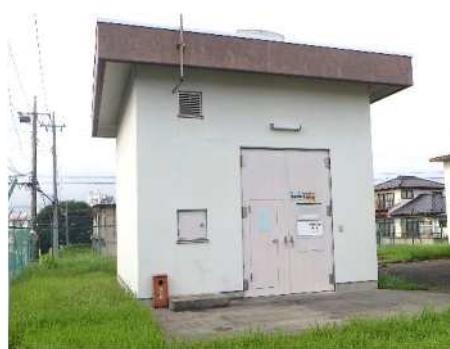
自家発電設備
