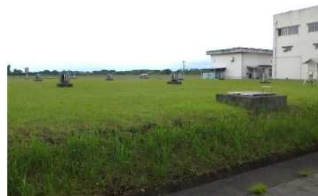
2号配水池：補強 (基礎杭の増し杭、増打コンクリート)
