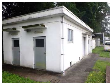
県水受水電気室
