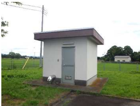
取水ポンプ室
