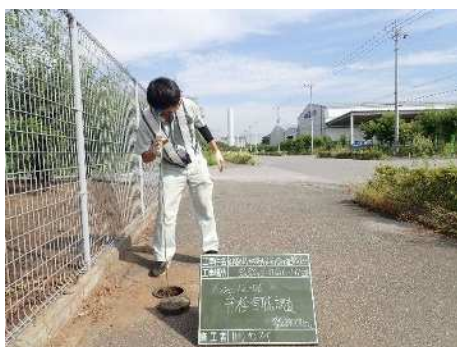
漏水調査状況
