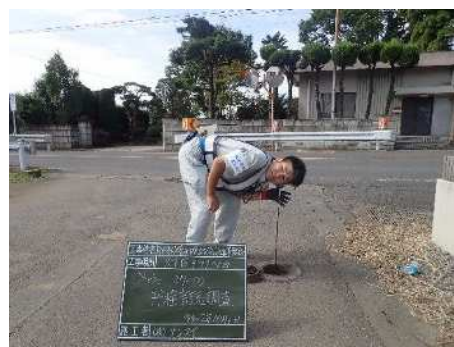
漏水調査状況
