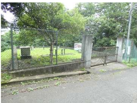
西田井浄水場配水池（配水場）
