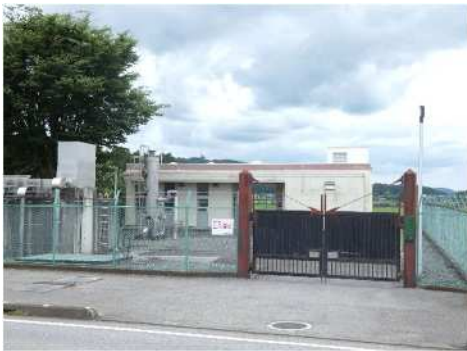
西田井浄水場
