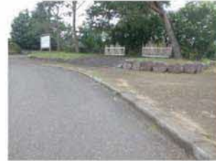
⑬歩車道境界縁石(コンクリート製)
