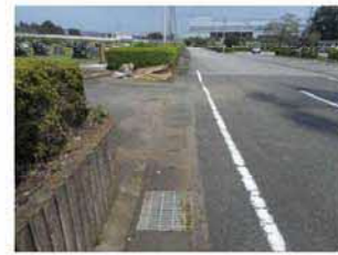
③ 計画地隣接側溝の状況
