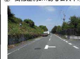
⑤ 高低差約2mある公共下水道
