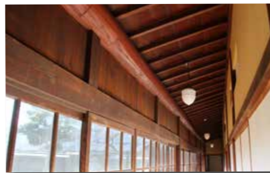
▲一本の杉で作られた廊下の桁（けた）
