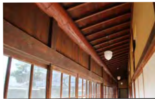
▲一本の杉で作られた廊下の桁（けた）
