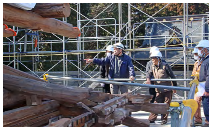
足場に登り屋根部分の説明を受ける参加者たち
