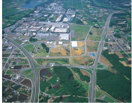
真岡インターチェンジ
