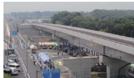
▲会場となった清南大地高架橋下付近
