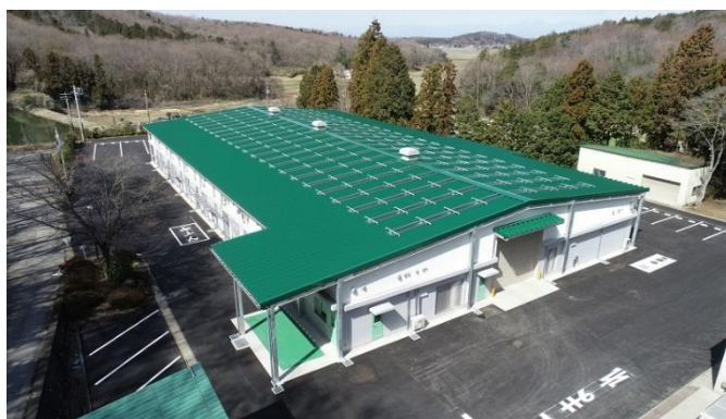
真岡市リサイクルセンター（平成31年4月稼働開始）
