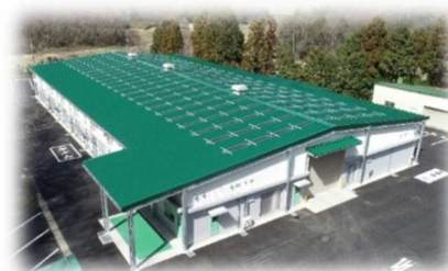
真岡市リサイクルセンター
