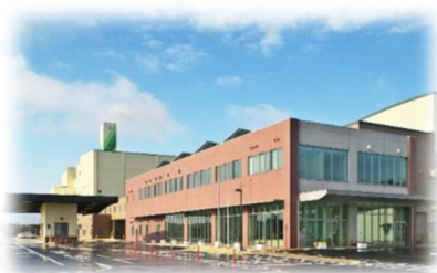
芳賀地区エコステーション
