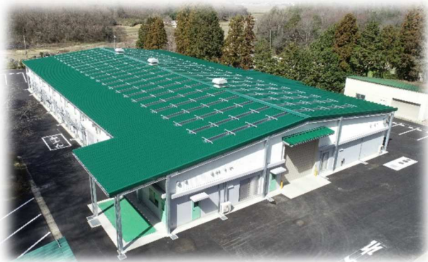
真岡市リサイクルセンター
