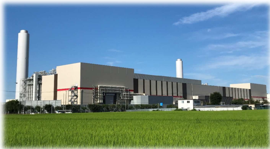
株式会社コベルコパワー真岡 真岡発電所
