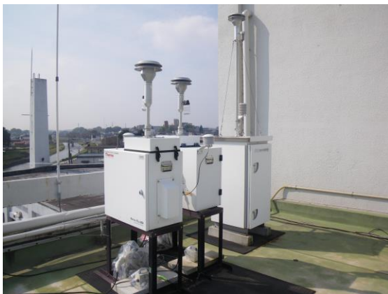
PM2.5測定器（市役所屋上に設置）
