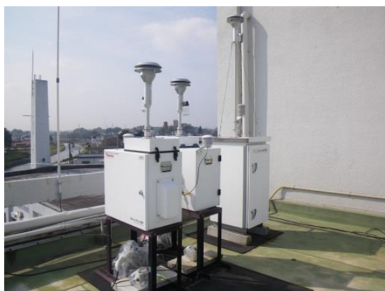
PM2.5測定器（市役所屋上に設置）
