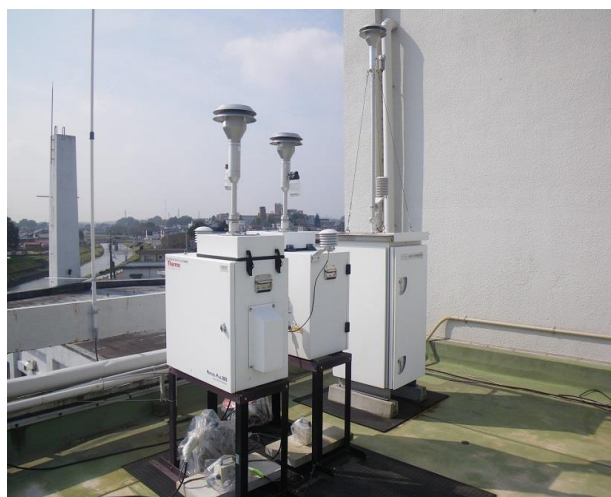
PM2.5測定器（庁舎屋上に設置）
