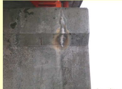
橋台のひびわれ、遊離石灰 (白色の析出物)
