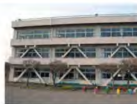
耐震工事事例 山前小学校教室棟耐震補強工事
