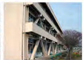
耐震工事事例 山前小学校教室棟耐震補強工事
