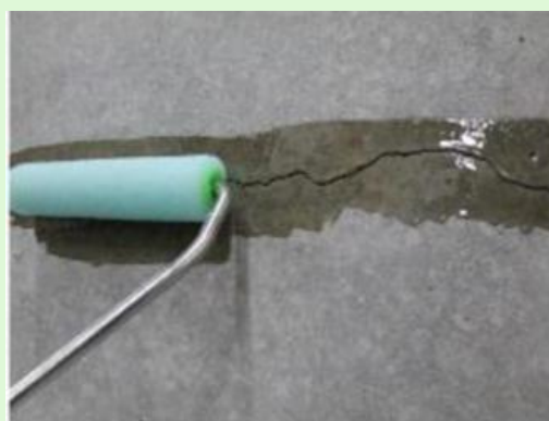
新工法（塗布・浸透型ひび割れ補修工法）
