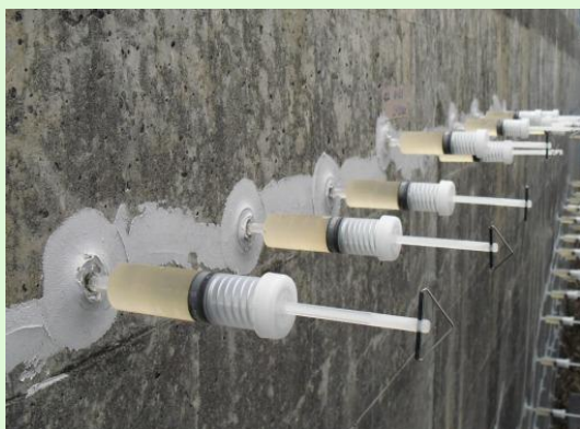
従来工法（低圧注入工法）
