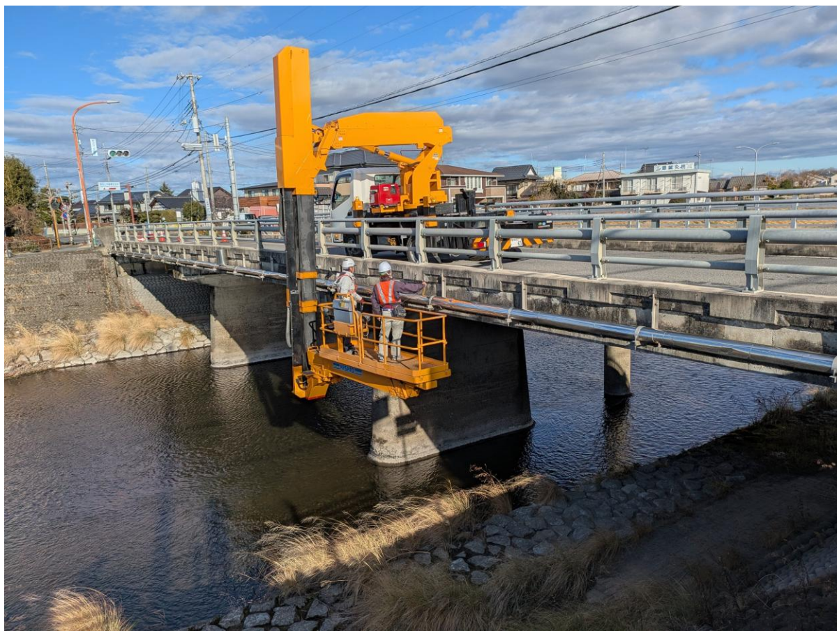
妹内橋（令和7年度（2025年度）定期点検の様子）
