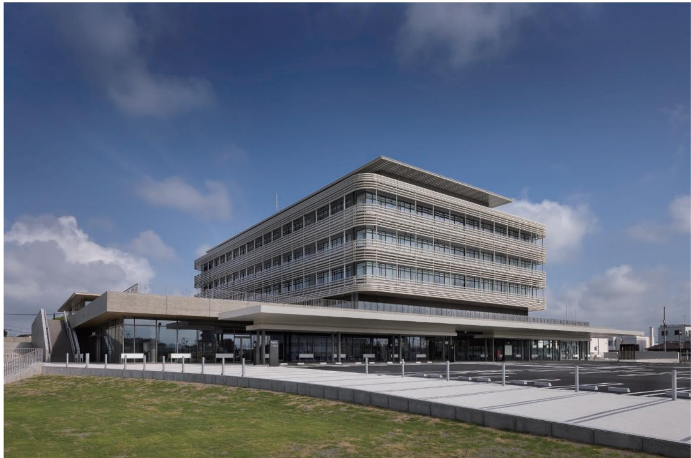
1階は大きな平面として多くの市民が利用する窓口を集約し、その屋上に多様な市民活動が可能な広場と壁面がガラス張りの多目的空間を併設、2階から5階までは効率的な執務スペースを設けた配置である。市民が気軽に利用できるオープンスペースがあり、開かれた印象を与えている。真岡木綿をモチーフにしたルーバーは、先端を2段形状とした4種類の横ルーバーを組み合わせることで縦糸と横糸が重なり合うような表情を見せ、ルーバーと外周バルコニーで日射による熱負荷の軽減も図っている。公共施設という端正な建物の威圧感を緩和するとともに、市民のシンボルとなる景観を演出している。
