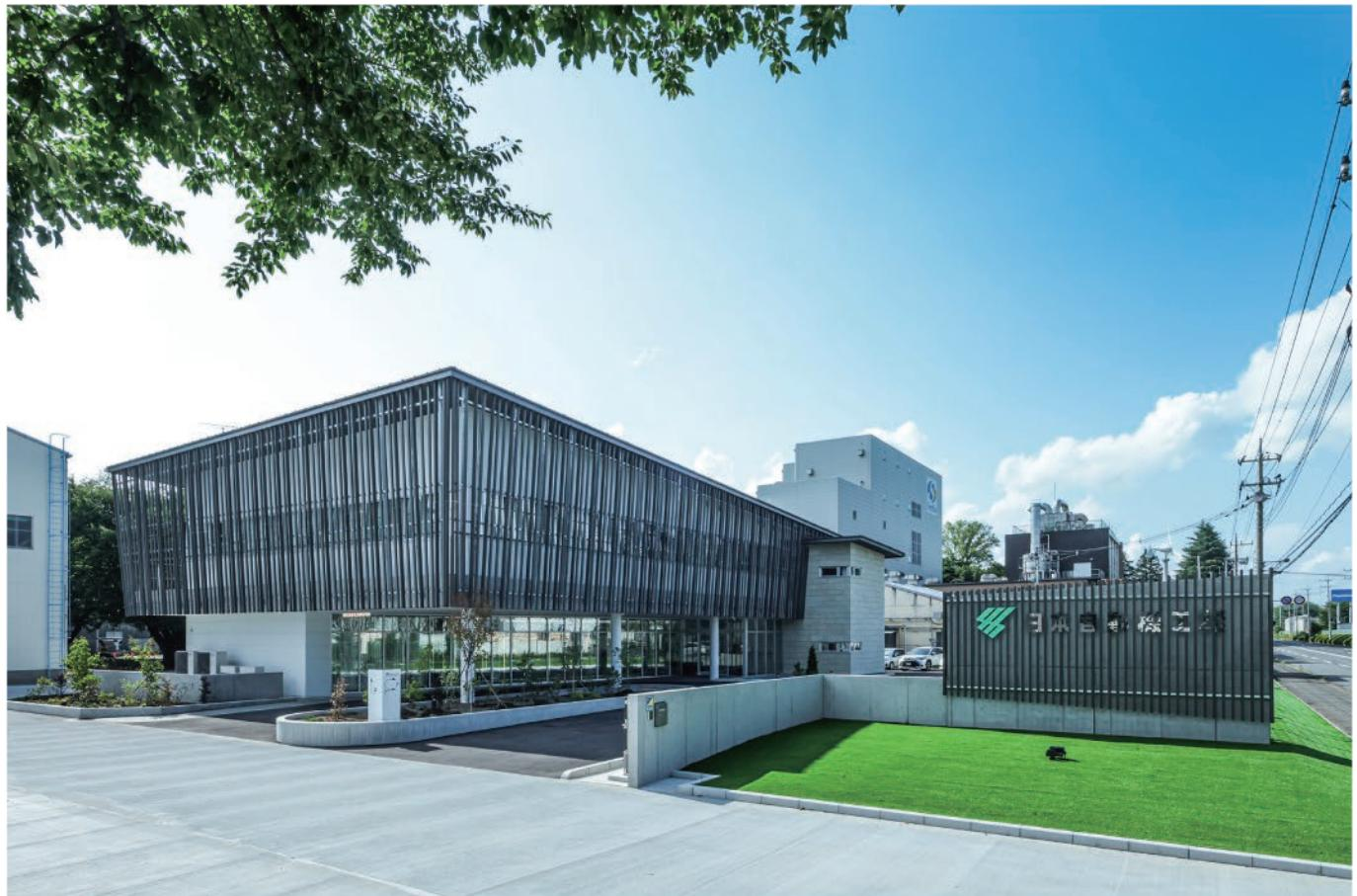
工業団地に立地する日本自動機工㈱真岡工場が創業 50 年を迎え、次の 50 年に向けて建築した 2 階建ての事務所である。建物の形状は、周囲の景観を取り込み、敷地内の桜を事務所内のどこからでも望める逆 L 型であり、動線など働きやすさに配慮された空間としている。外観は深岩石とガラス、外皮としてのルーバーで構成され、浮遊感のある新たな企業イメージを表しており、企業の将来性を感じることができる。外壁面に対して傾斜をつけ、色彩や太さにも変化をつけたルーバーは深岩石と相性が良く、建物の圧迫感がこのルーバーによって軽減されているとともに、国道からの建物の景観を和らげている。
