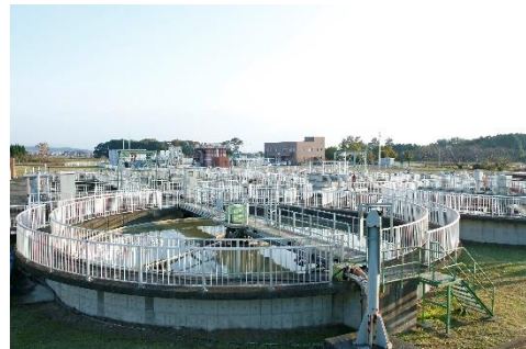
真岡市水処理センター
