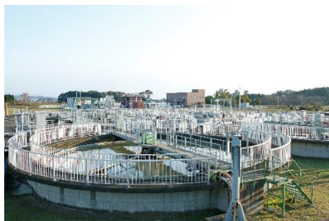
真岡市水処理センター
