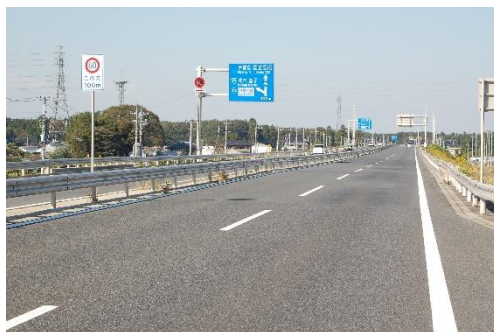
一般国道 408 号（鬼怒テクノ通り）
