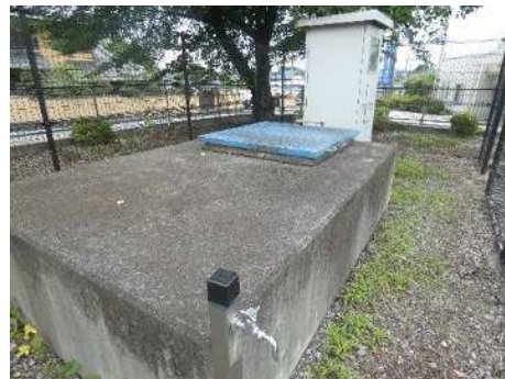
取水ポンプピット
