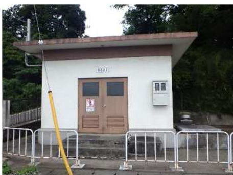
県水受水設備
