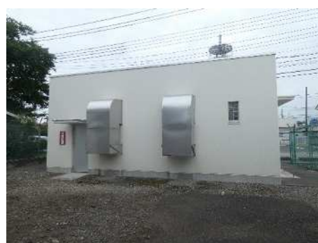
自家発電設備
