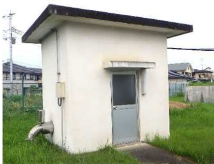
取水ポンプ室
