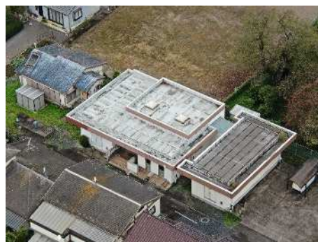
管理棟（地下配水池）
