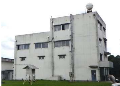
管理本館（管理棟・ポンプ井）：補強 (基礎杭の増し杭、増打コンクリート)
