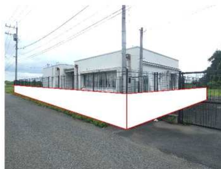
防水壁による浸水対策イメージ
