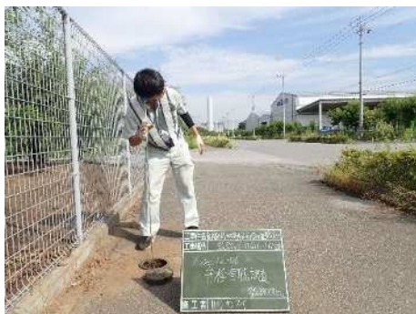
漏水調査状況
