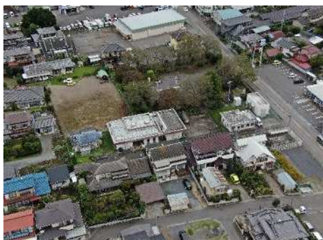
久下田浄水場
