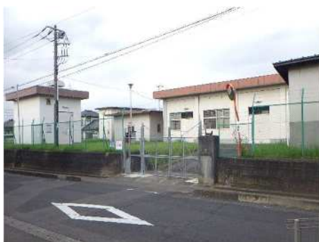
大谷台配水場
