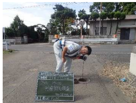
漏水調査状況
