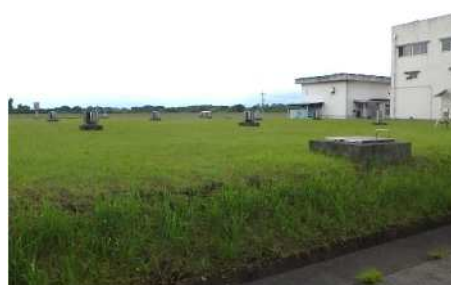
2号配水池：補強 (基礎杭の増し杭、増打コンクリート)
