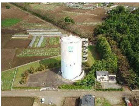
石法寺浄水場高架水槽（配水場）
