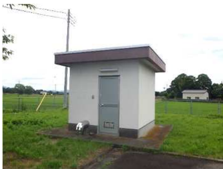
取水ポンプ室
