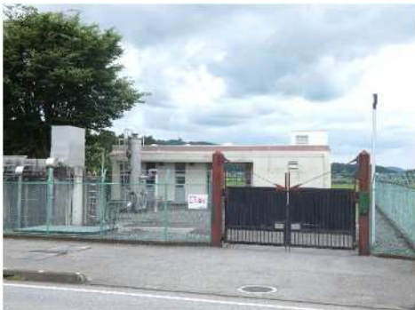
西田井浄水場
