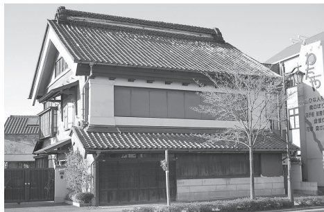
歴史的建造物の久保邸(荒町地内)
