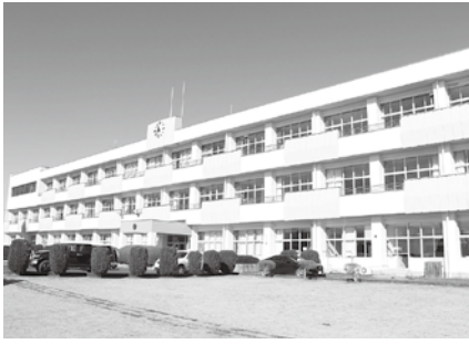
耐震改修が完了した物部中学校
