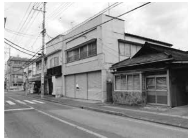
まちなか保健室開設予定地(真岡駅前)
