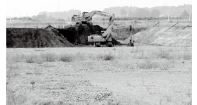
工事が進む二宮遊水地
