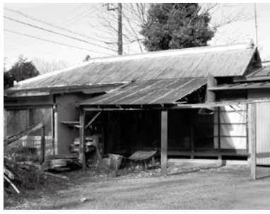
市内の空き家
