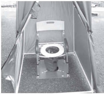
マンホールトイレ
