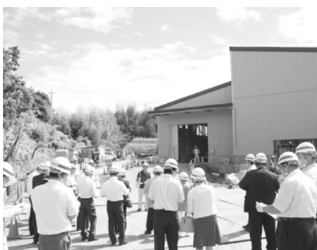
する浸出水処理施設の建設現場を見学しました。
