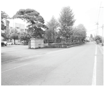
市道116号線(山前中学校北側)
