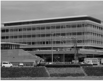
建設中の新庁舎
