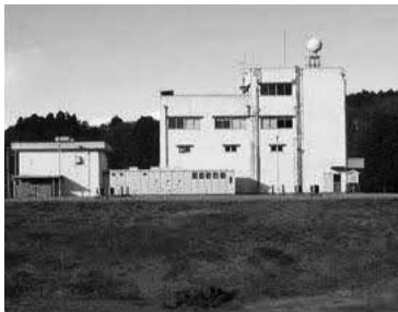
水道施設(石法寺浄水場)
