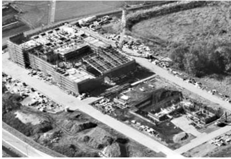
建設中の芳賀地区広域ごみ処理施設
