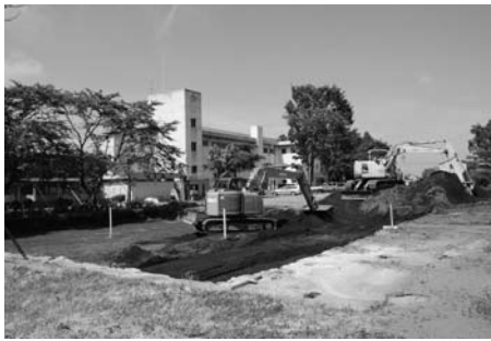
グラウンドの土の入れ替え工事が進む西田井小学校
