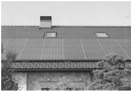
太陽光発電パネルを備えた住宅
