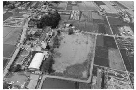
竜巻の被害を受けた西田井地区
