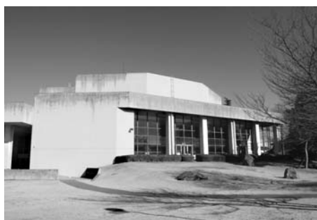
改修予定の真岡市民会館
