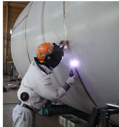
溶接作業の様子
