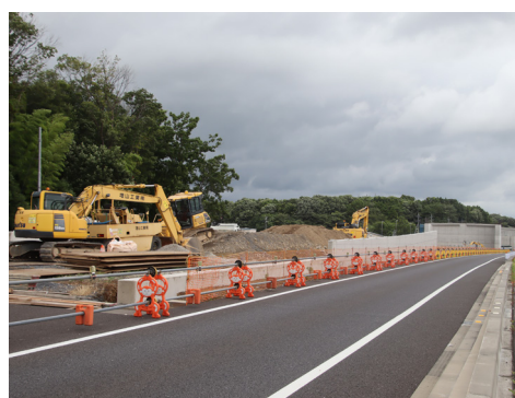
工事現場の様子
